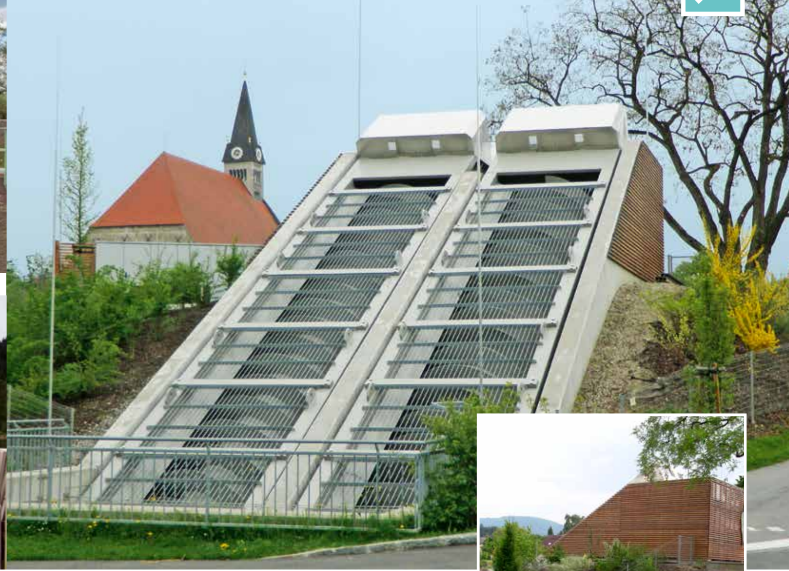
Sel baskınından korunmak için kullanılan bu Arşimet burğu pompası Oberndorf (Austria)'da dır
