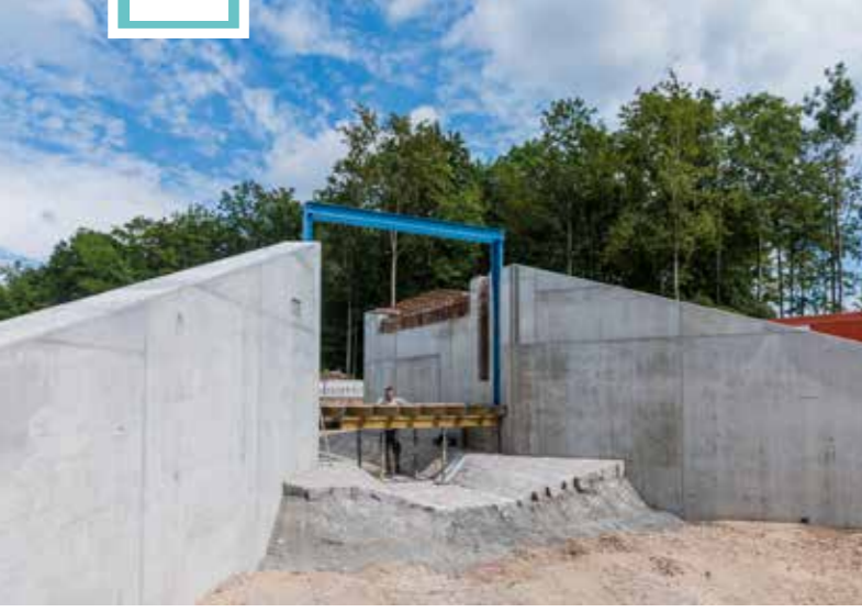
Koruma kapak kılavuzlarının montajı
