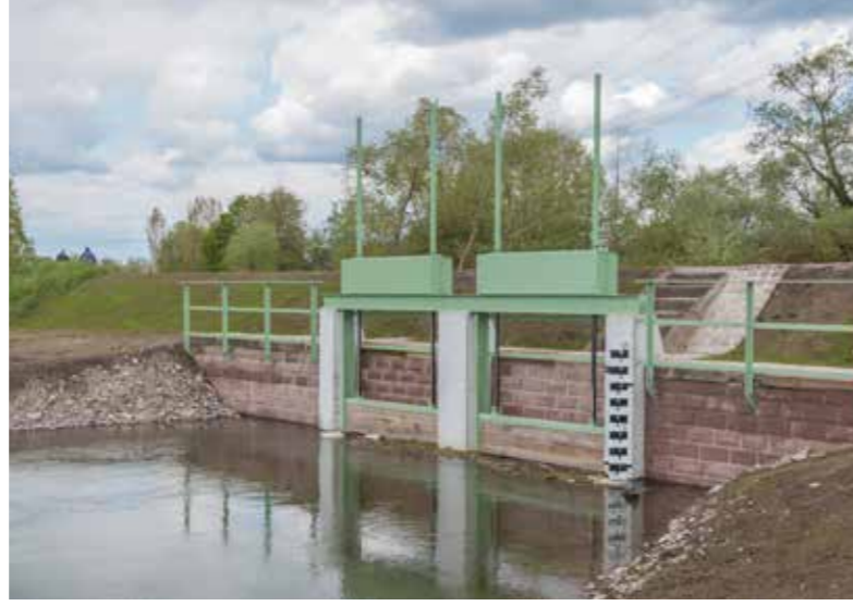
Ahşap panelli bent kapakları
