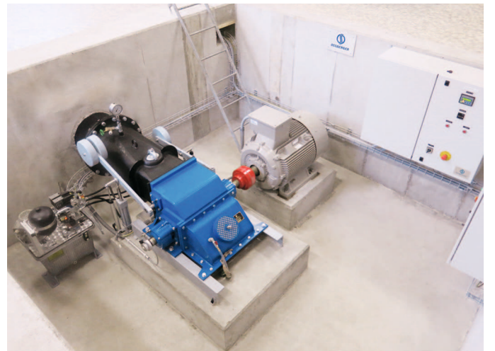
Çapraz akışlı türbin OSSBERGER hidroelektrik jeneratörünün tipik yerleşimi
